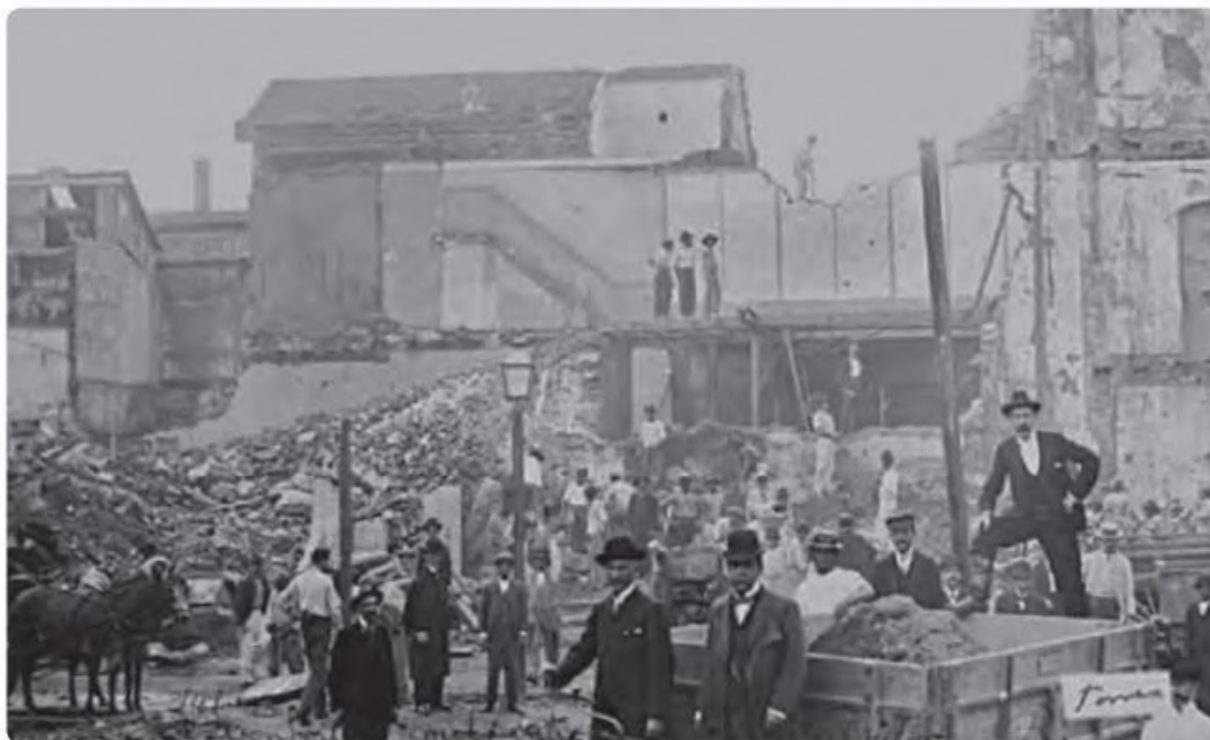
Demolições para a construção da Avenida Central, Rio de Janeiro, RJ, c. 1904.
